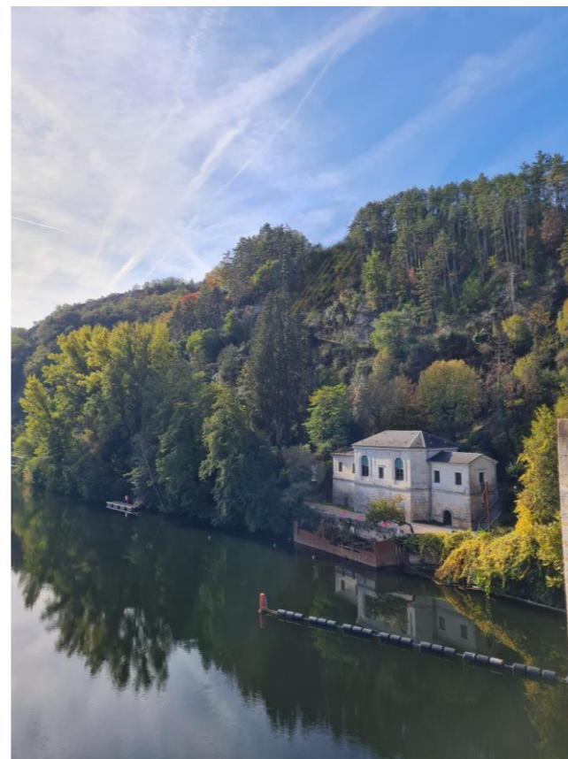
Figure 12 : Vue du Pont Valentré T2
