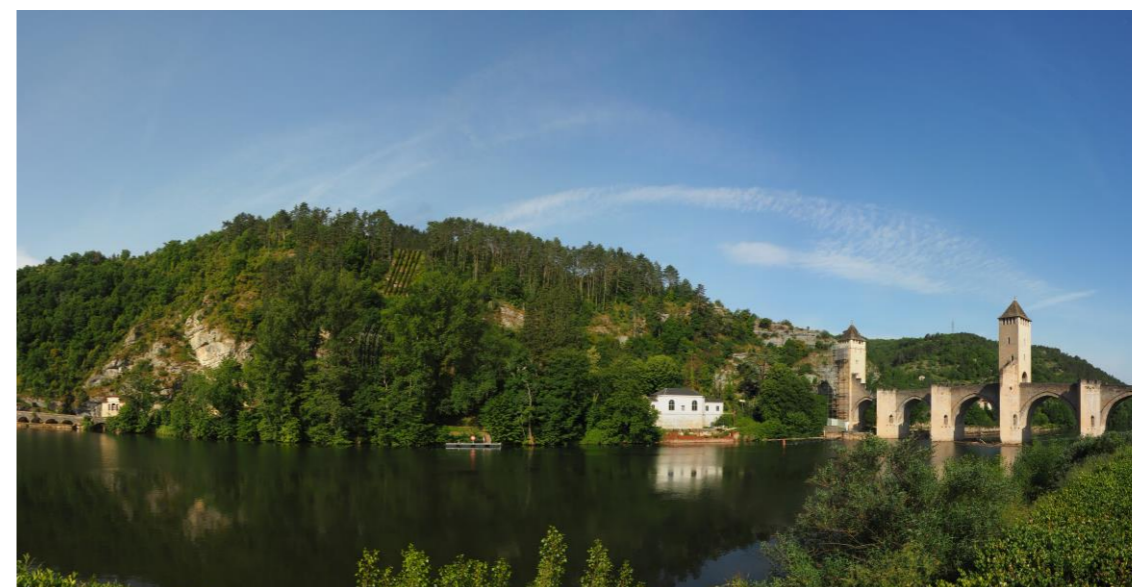
Figure 14 : Vue des quais T1
