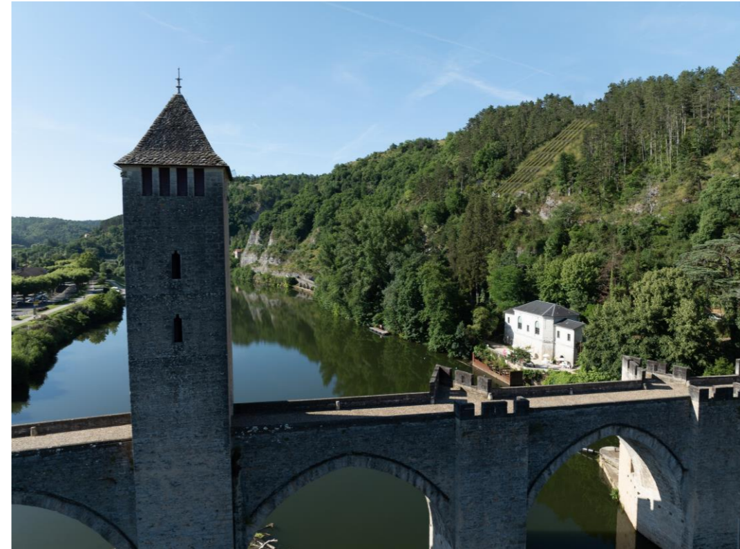
Figure 8 : Vue du pont Valentré T1
