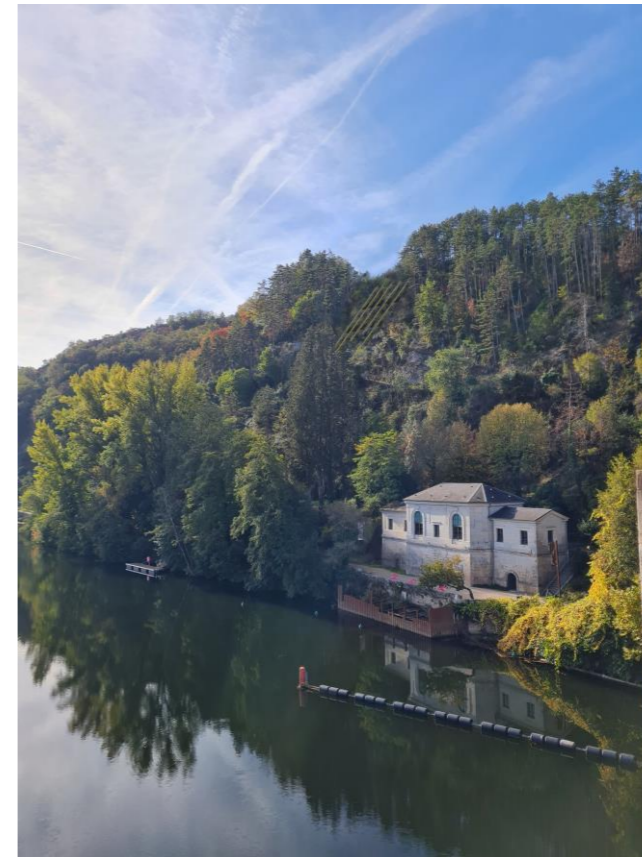
Figure 11 : Vue du pont Valentré T1
