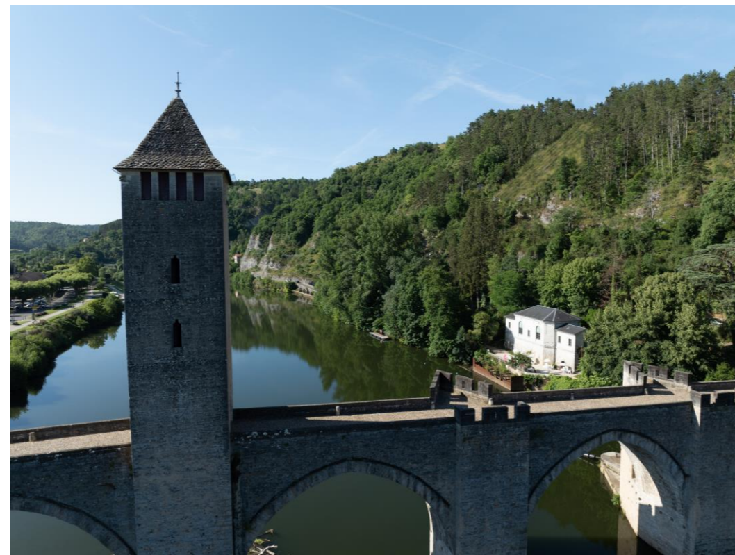
Figure 9 : Vue du Pont Valentré T2
