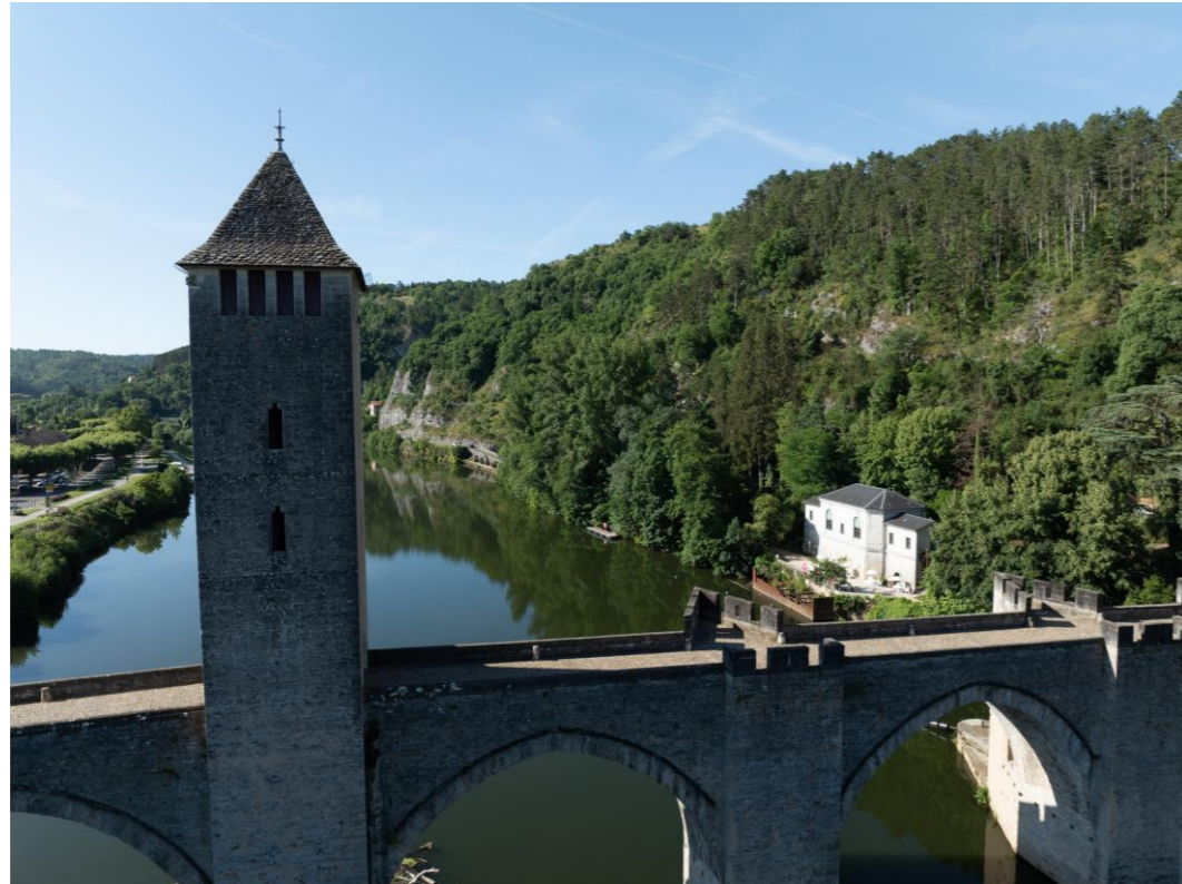
Figure 7 : Vue du pont Valentré T0
