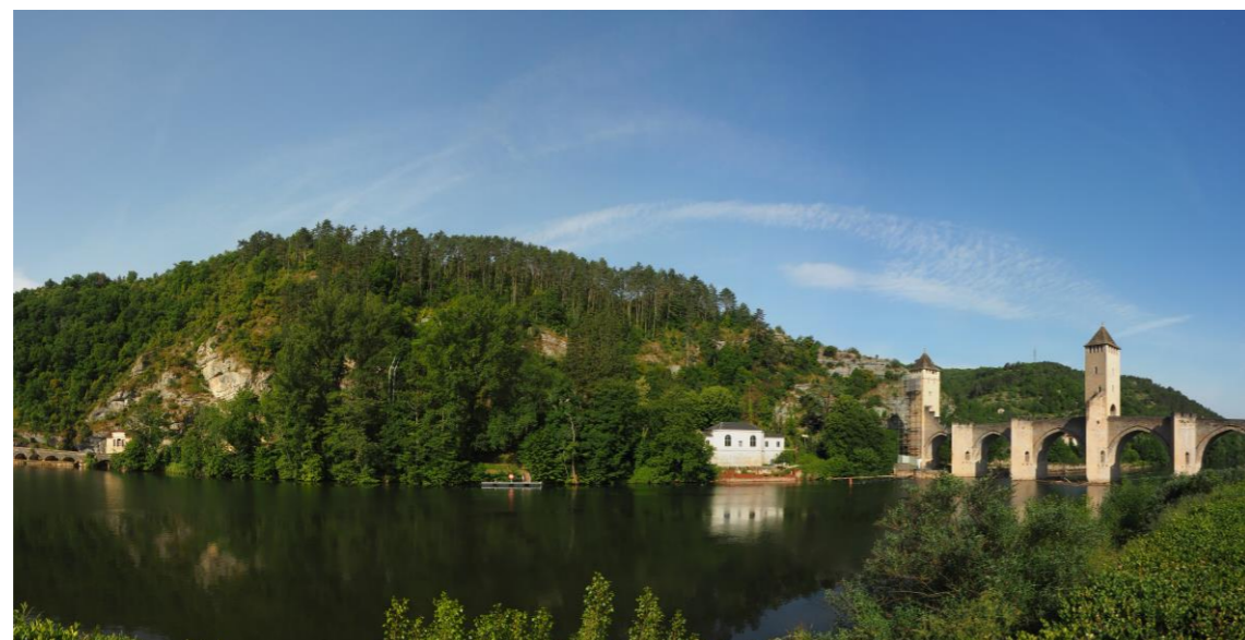
Figure 13 : Vue des quais T0
